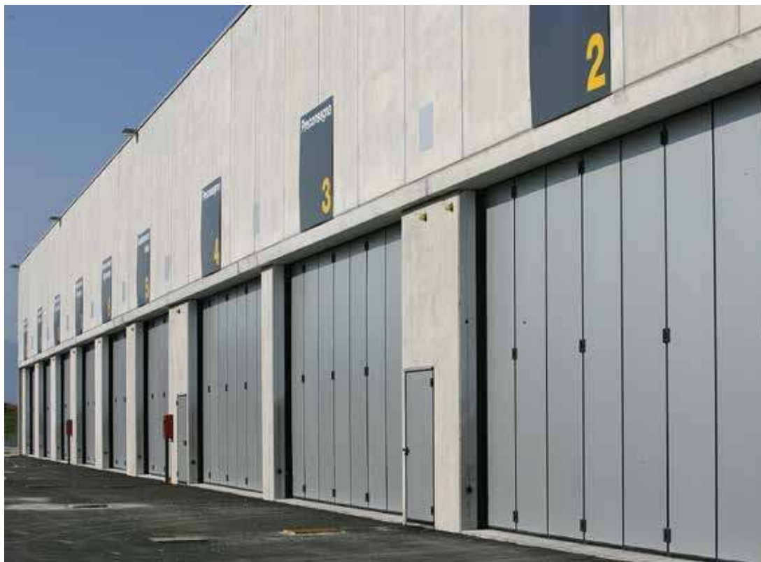
Vista esterna portoni con apertura unico impacco 8 + 0 ante motorizzati
