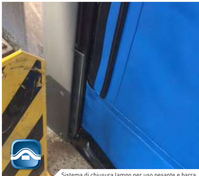
Sistema di chiusura lampo per uso pesante e barra inferiore FlexEdge
